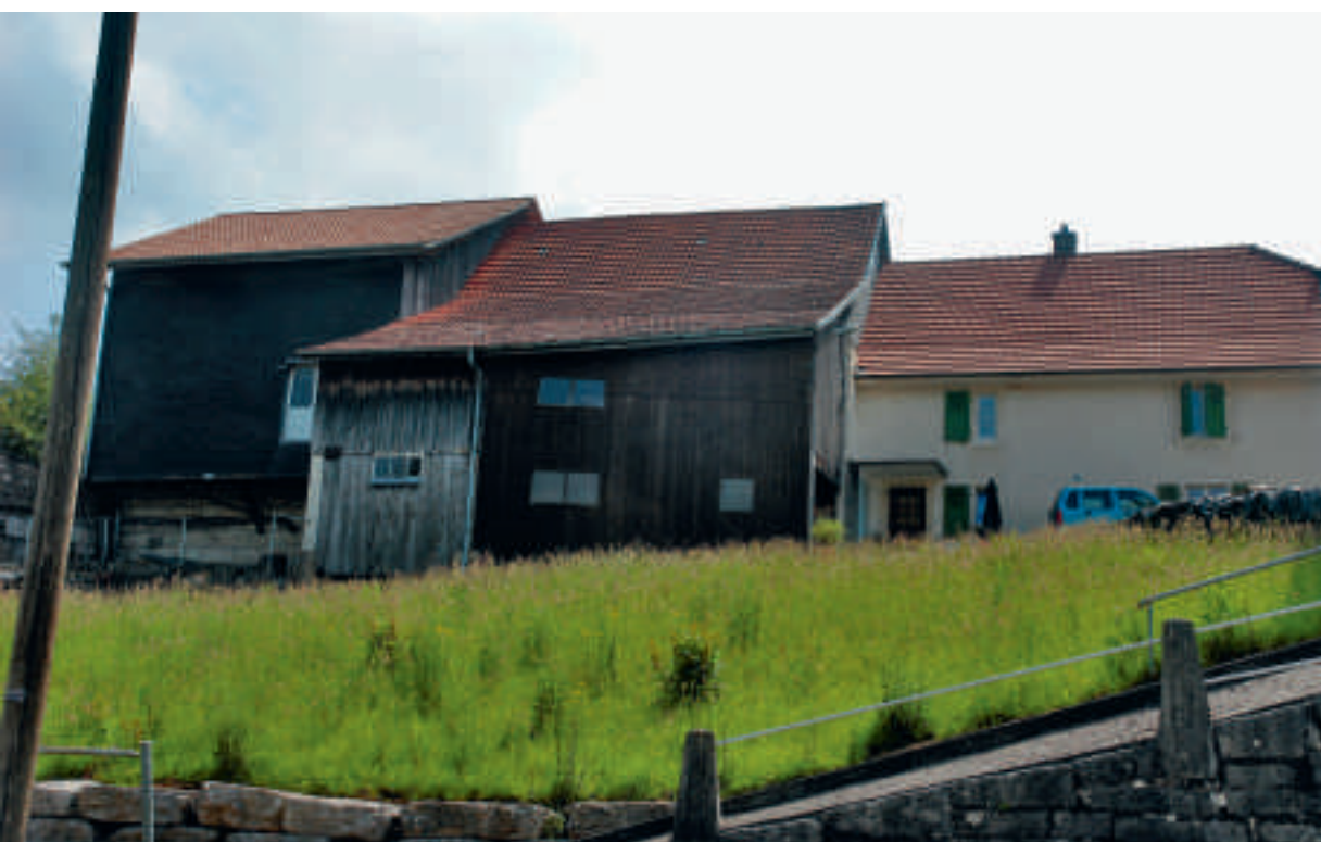
In Fontenais wurden vier Wohnungen in eine alte Scheune eingebaut. Die Parkplätze befinden sich unter dem Gebäude.
